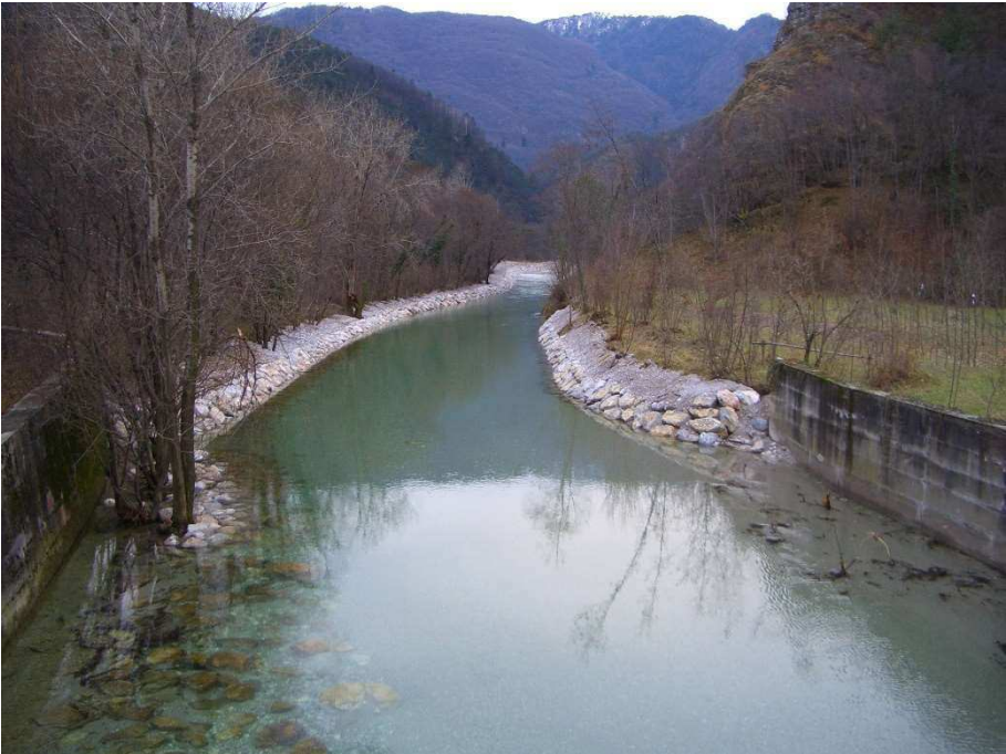
Figura 9 - Tratto B visto dal ponte strada – inverno – 13.12.2008
